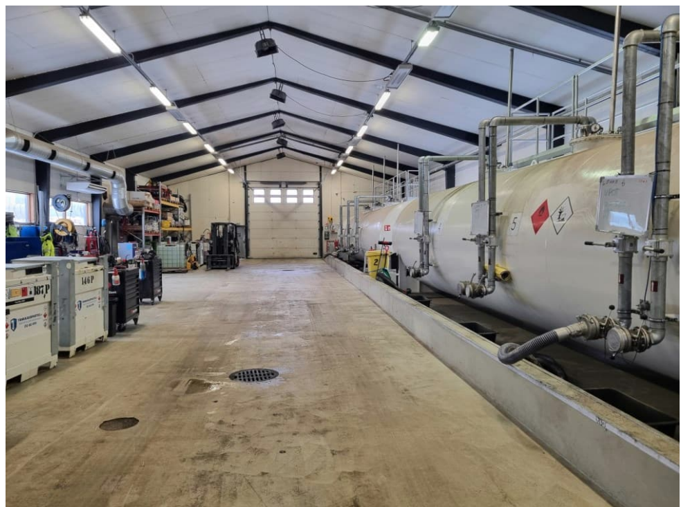
Kuva 2 Toimipaikka sisältä. Polttoainesäiliöt ovat suoja-altaissa ja säiliöiden täyttö ja polttoaineiden nouto tapahtuvat sisätiloissa.
