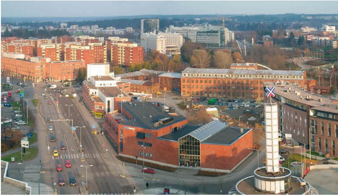
Kuva Kielotornista kohti kaava-aluetta. Etualalla korttelin eteläosan liikerakennus, kauempana Kellan rakennus, jonka tilalle kaava mahdollistaa uutta rakentamista.
