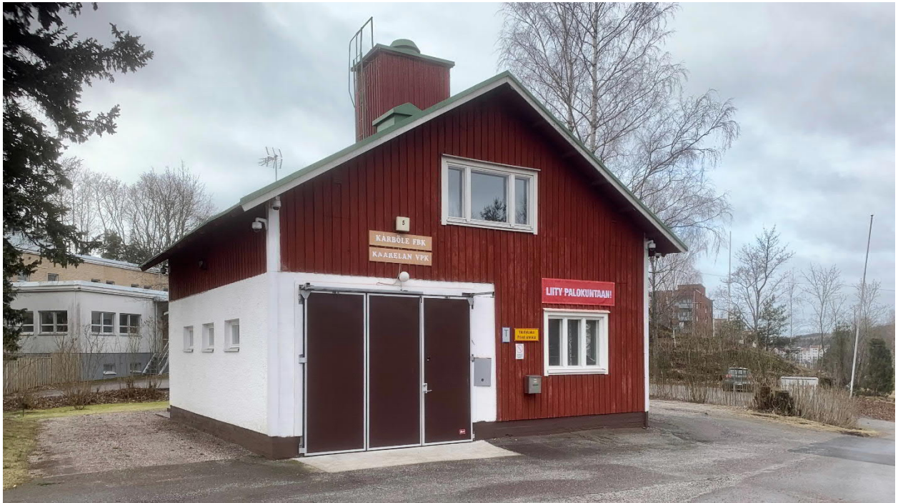
Kaarelan vpk:n talo, Palotie 5, rakennusperintökohde vuodelta 1950.
