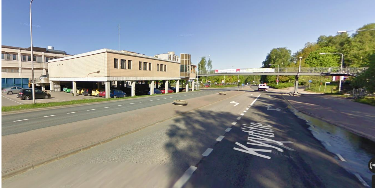
Kuva 26. Katunäkymä Kyytitien varresta kohti purettavaa liikerakennusta. Myös kadun ylittävä silta tullaan purkamaan. Kuvan lähde: Google street view.
