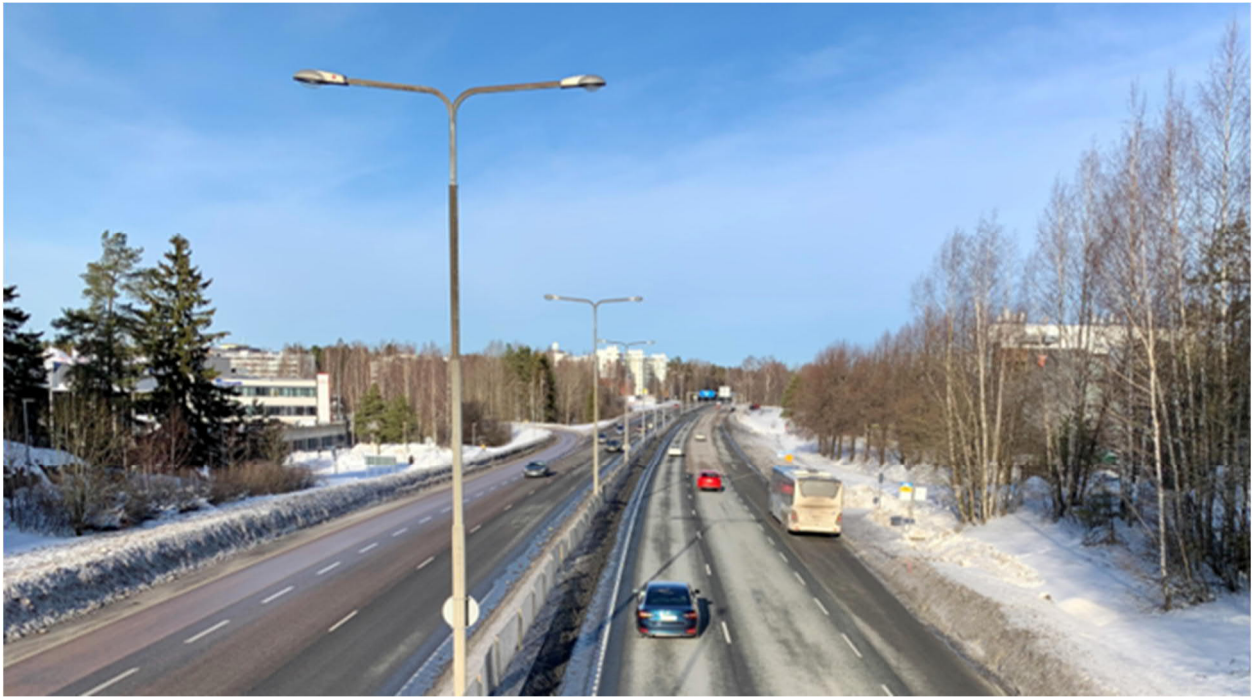
Hämeenlinnanväylä Palotien sillalta pohjoiseen.
