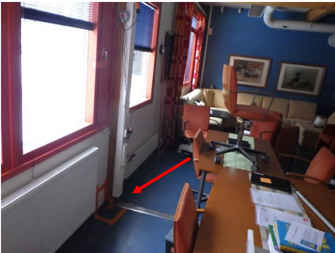
Kuva 19. Tilan 10 ulkoseinän ja alapohjan rakenneavaus
