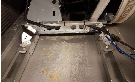
Kuva 94. Tuloilmapuhalin TK03 on pölyinen.
