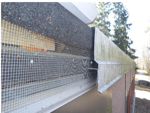
Kuva 76. Rästästuuletus on suunnitelmien mukainen.
