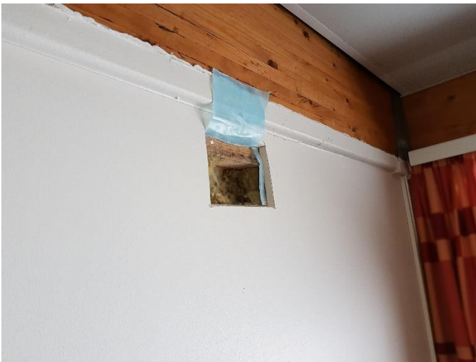
Kuva 29. Ulkoseinärakenteen yläosan rakenneavaus
