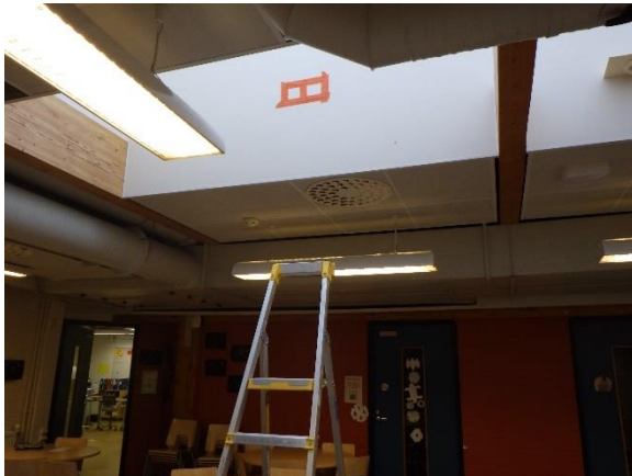
Kuva 78. Tilan 44 kattoikkunan valokuilun seinän rakenneavaus
