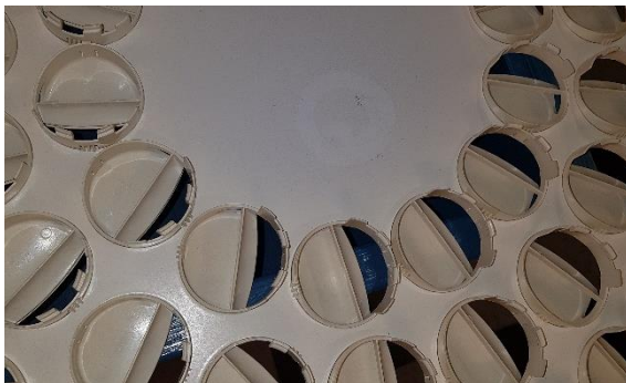
Kuva 110. Pölyinen tuloilmapäätelaite.
