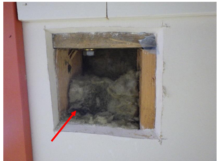
Kuva 10. Mineraalivilloissa oli runsaasti ilmavuotojen aiheuttamaa tummentumaa
