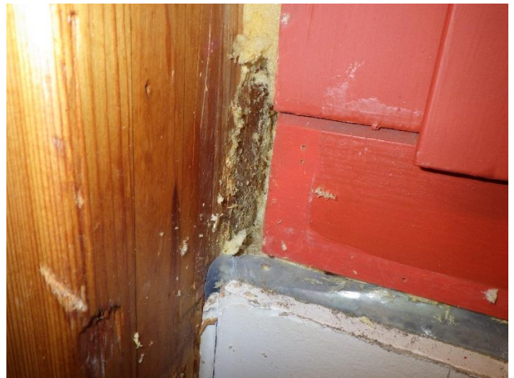
Kuva 24. Uretaanivaahdotusta otettiin materiaalinäyte mikrobimääritystä varten
