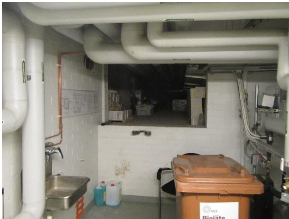
Kuva 16. Kuvaa kellarista kohti putkitunnelia
