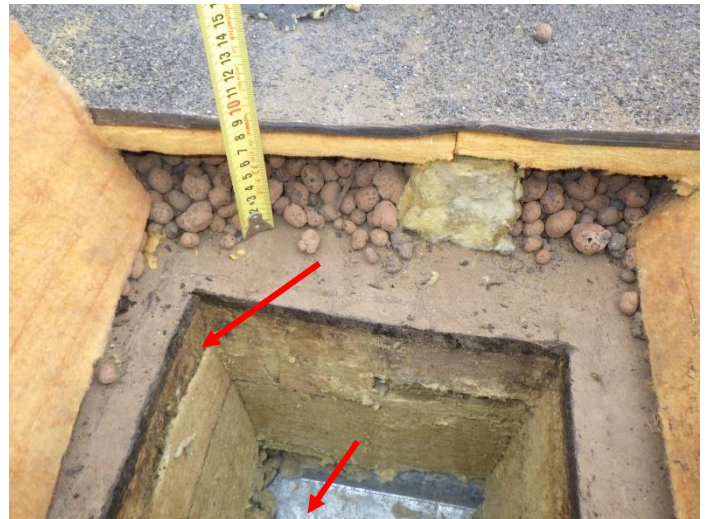
Kuva 60. Rakenneavauksesta otettiin materiaalinäytteitä mikrobimääritystä varten
