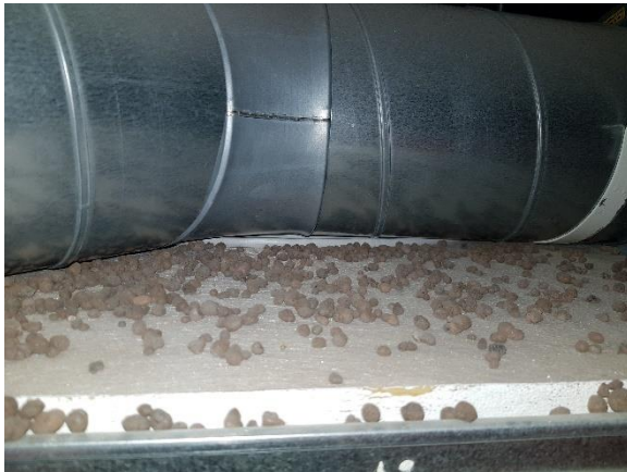
Kuva 66. Alaslasketun katon päällä on IV-konehuoneiden läheisyydessä runsaasti rakennusjätettä.
