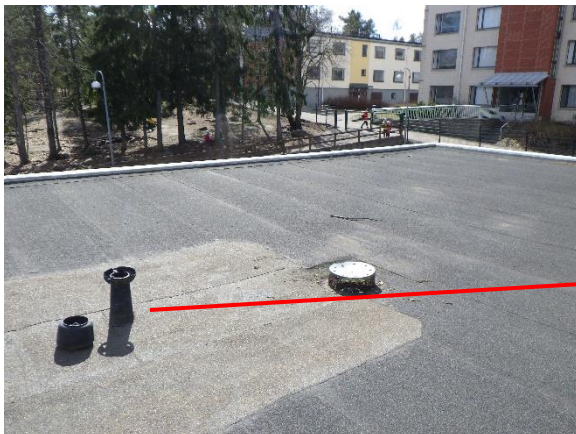
Kuva 62. Vesikattoa on korjattu päiväkodin kohdalta.
