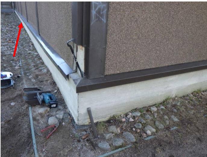
Kuva 5. Rakenneavauksen läheisyydestä avattiin pellityksiä rakenteen selvittämiseksi. Nuolella merkitty sokkelin avaus.
