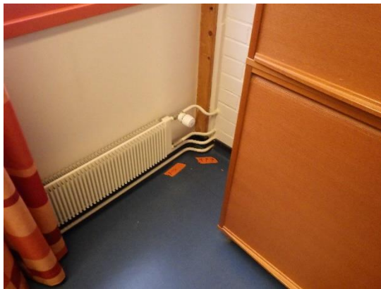
Kuva 29. Tilassa 19 havaittiin vuotokohta alapohjan ja pilarin liitoskohdasta
