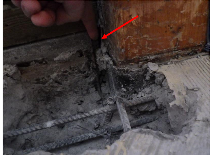
Kuva 22. Radonkermi ei ollut yhtenäinen. Saumassa noin 10 mm rako
