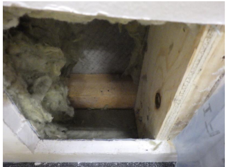
Kuva 14. Mineraalivilloissa oli pientä ilmavuotojen aiheuttamaa tummentumaa
