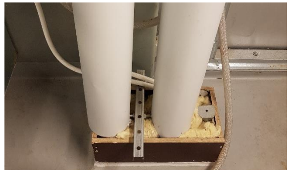
Kuva 85. Läpivienti ilmanvaihtokonehuoneessa. Läpivienti on pyritty tiivistämään lasivillalla.
