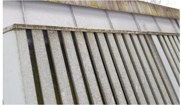
Kuva 127. Raitisilmasäleiköt ovat likaiset.
