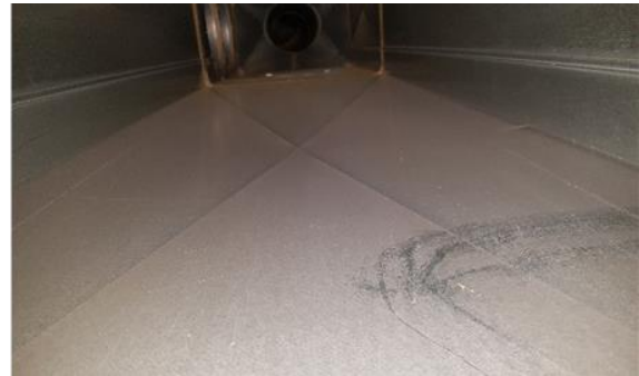
Kuva 123. Tilan 74 tuloilmakanavaa puhdistusluukun kautta. Pintapölynkoostumusnäyte 2.
