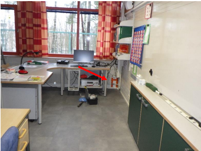
Kuva 1. Tilan 41 ulkoseinän alaosan rakenneavaus
