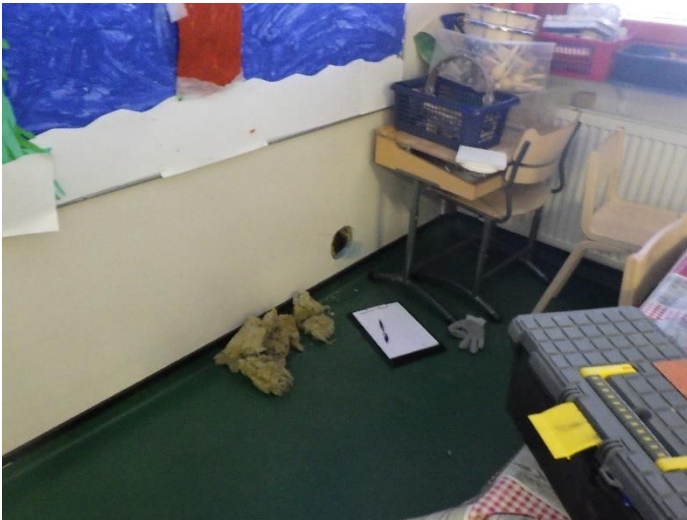
Kuva 31. Ulkoseinän rakenneavaus
