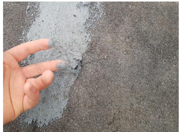
Kuva 71. Massa oli tutkimuksen aikana tahmeaa.
