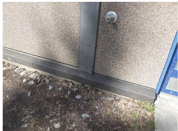
Kuva 12. Rakennuksen länsisivulla sokkelin korkeus on matala
