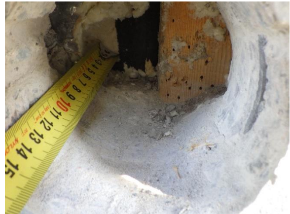
Kuva 47. Kuvassa tilan 38 pilarin alaosa. Tilan 38 ja tilan 41 pilareiden alaosien kosteus oli noin 17 paino-%.
