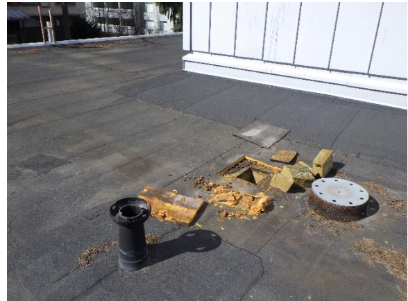
Kuva 75. Tilan 39 vesikaton rakenneavaus.
