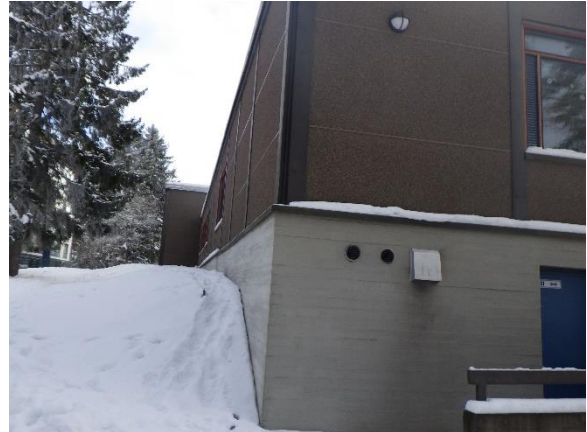
Kuva 8. Kellarin kohdalla sokkelin korkeus on suurimmillaan. Itäisivulla maanpinta kallistuu rakennuksesta poispäin
