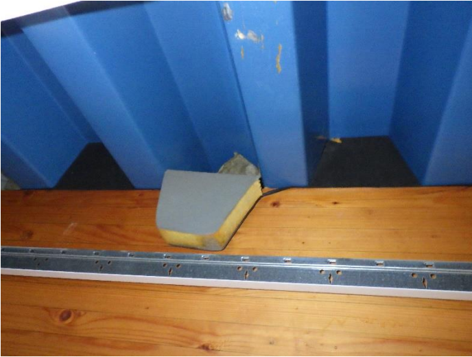
Kuva 3. Rakenneavauksen yläpuolelta avattiin alaslaskettuja kattoja. Puupalkin ja profiilipellin liitoskohtaa on tiivistetty vaahtomuovilla
