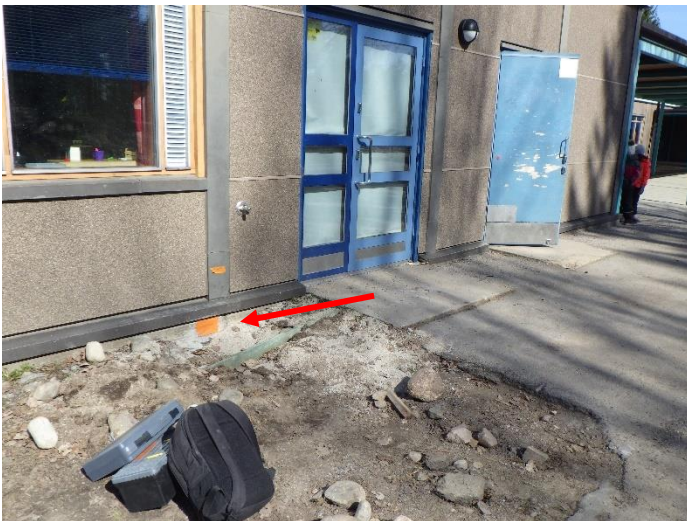
Kuva 25. Sokkelin rakenneavaus
