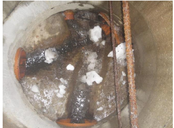
Kuva 18. Sadevesikaivot ovat betonirengaskaivoja.
