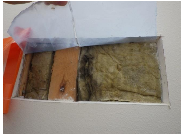
Kuva 79. Mineraalivilloissa on runsaasti ilmavuotojen aiheuttamaa tummentumaa
