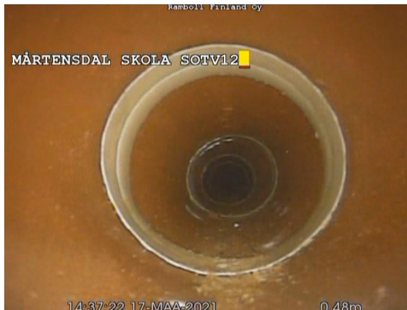
Kuva 32. Yleiskuva tiilisalaojaputkesta.
