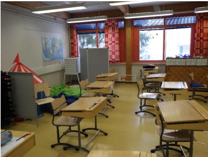
Kuva 13. Tilan 88 ulkoseinän rakenneavaus
