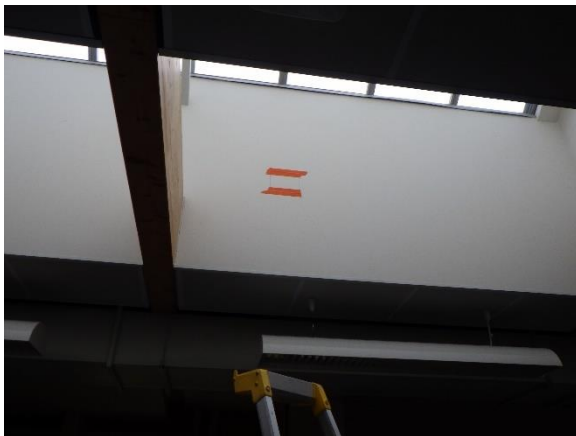
Kuva 80. Tilan 90 kattoikkunan valokuilun seinän rakenneavaus
