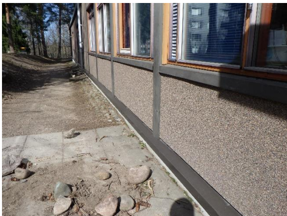
Kuva 11. Vuoden 2007 korjauksissa on pyritty muotoilemaan länsisivun maanpintaa kallistumaan rakennuksesta poispäin
