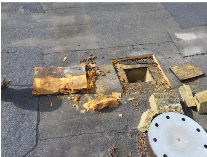
Kuva 57. Yläpohjan rakenneavaus
