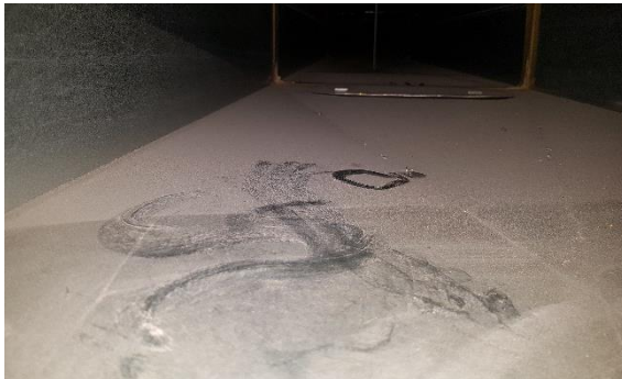
Kuva 122. Tilan 89 tuloilmakanavaa puhdistusluukun kautta. Pintapölynkoostumusnäyte 1.
