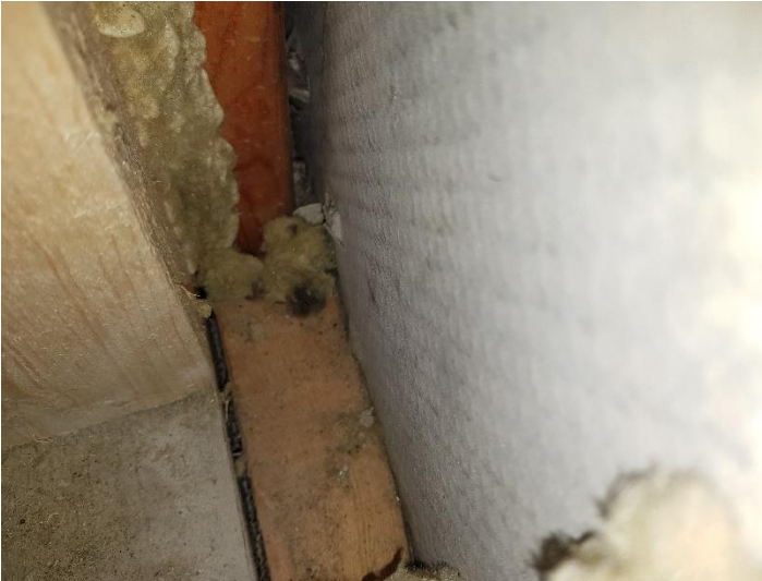
Kuva 35. Kuvaa rakenneavauksen sisältä.
