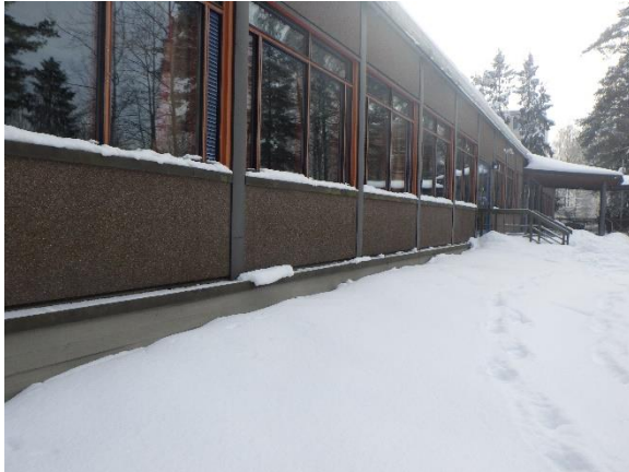
Kuva 7. Pohjoissivulla sokkelin korkeus on pääosin noin 300 mm ja maanpinta kallistuu rakennuksesta poispäin
