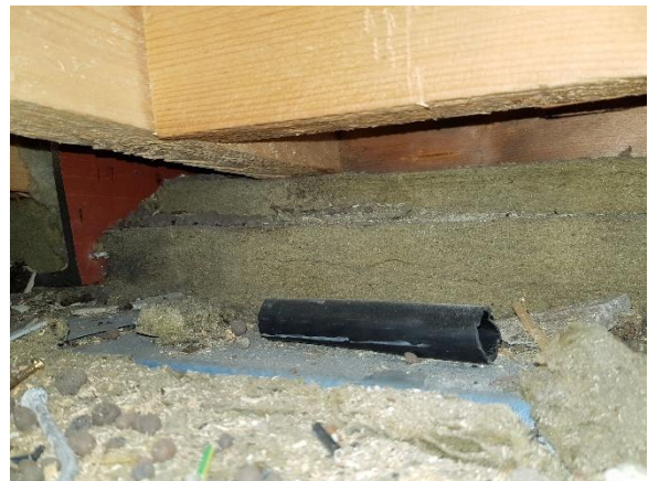
Kuva 55. Tarkastusluukusta näki vanhan vesikaton rakenteita.
