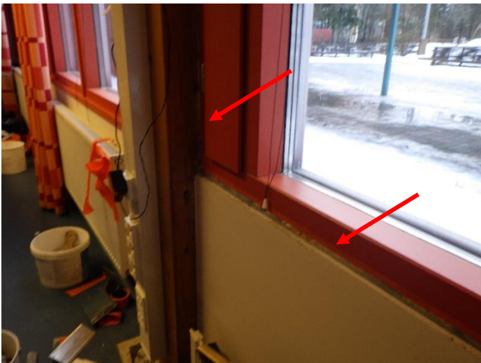
Kuva 23. Ikkunan liittymien tarkastus
