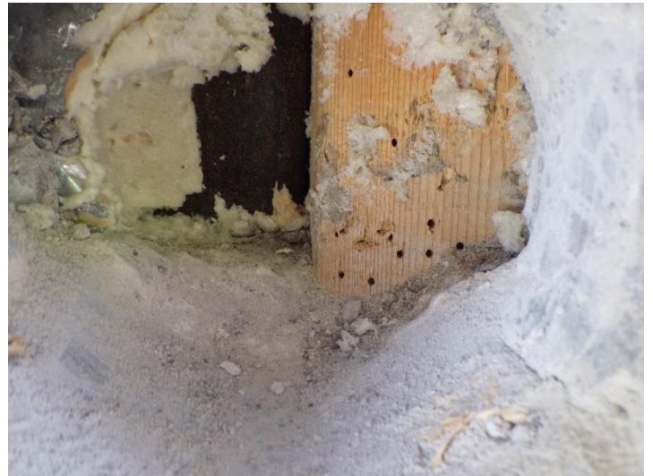
Kuva 38. Pilarin alaosassa ei havaittu lahovaurioita ja kosteus oli 17 paino-%
