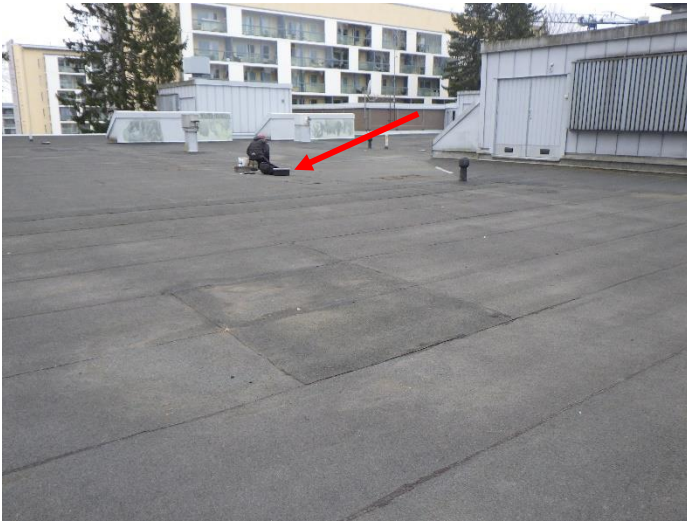
Kuva 53. Tilan 76 kohdalle tehty rakenneavaus
