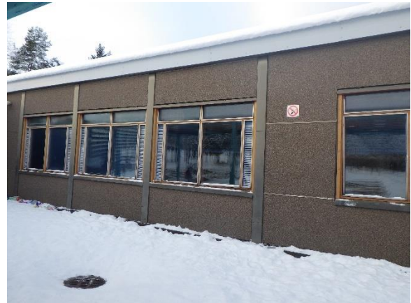
Kuva 32. Rakennuksen räystäät ovat lyhyet ja sokkelit matalat
