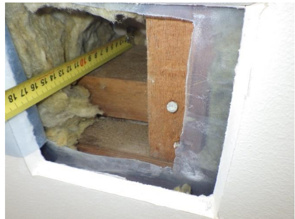
Kuva 81. Mineraalivilloissa oli pientä ilmavuotojen aiheuttamaa tummentumaa
