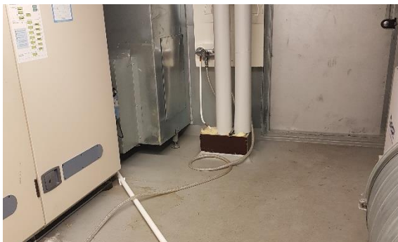
Kuva 128. Vesipiste on toteutettu ilman allasta ja letku on pikaliittimellä hanassa kiinni.
