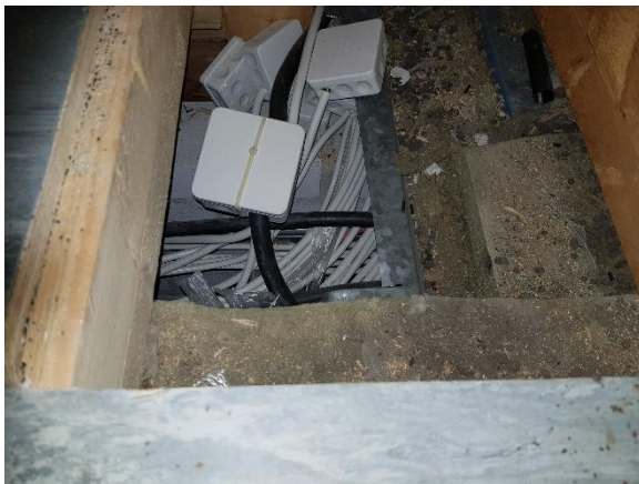
Kuva 54. Huoltokäytävän lattiassa oli tarkastusluukku, josta näkyi alkuperäisen vesikaton rakenteita. Tarkastusluukun kautta näki pukuhuoneen 31 alaslasketun katon yläpuolelle.
