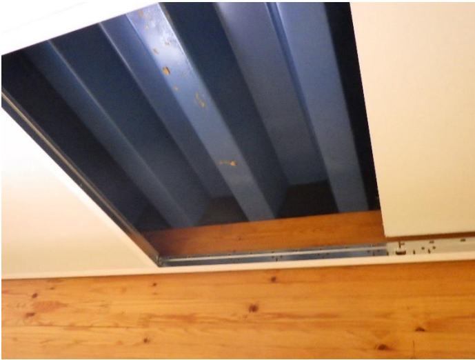
Kuva 11. Rakenneavauksen yläpuolelta avattiin alaslaskettuja kattoja
