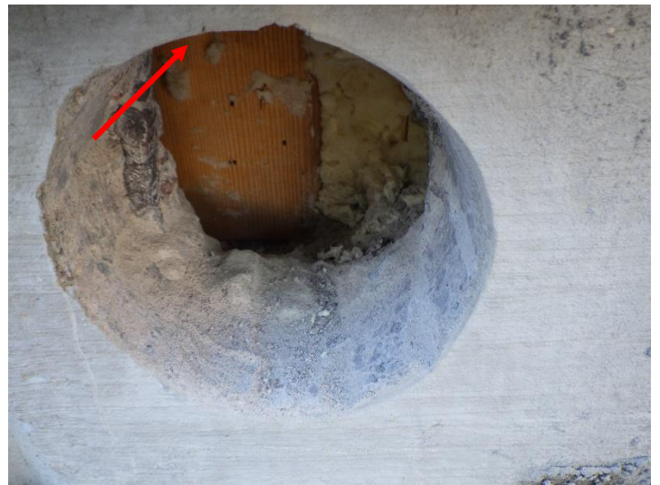
Kuva 6. Pilarin ja sokkelin välissä oli mineraalivillaa.
