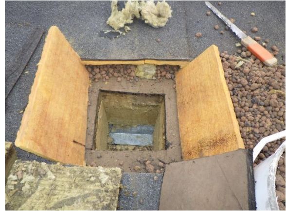
Kuva 73. Liikuntasalin vesikaton rakenneavaus.
