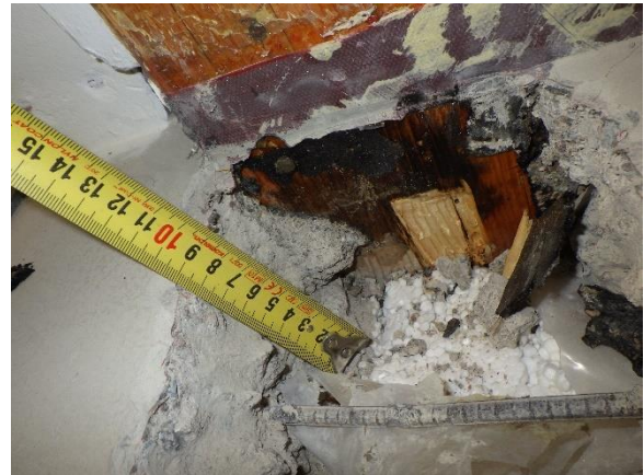
Kuva 21. Tilan 41 pilarin alaosan rakenneavaus. Ra- kenneavauksen kohdalla oli 90 mm betonia, muovi- kalvo ja 100 mm solupolystyreeniä. Puupilarin ala- osassa oli bitumikermi.
