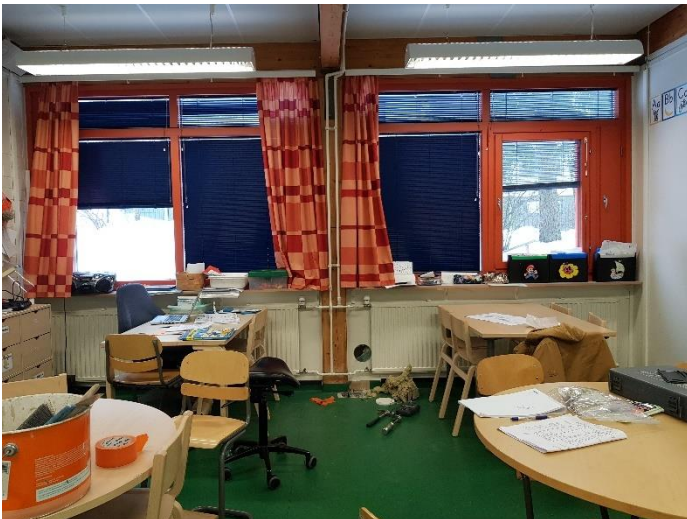
Kuva 33. Tilan 111 ulkoseinärakenteen ja alapohjan rakenneavaukset
