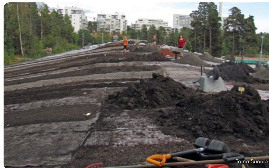
Sammalkatto rakennettiin suureksi osaksi talkoovoimin. Kuvassa Viides ulottuvuus -tutkimusryhmän jäseniä rehkimässä katolla.
