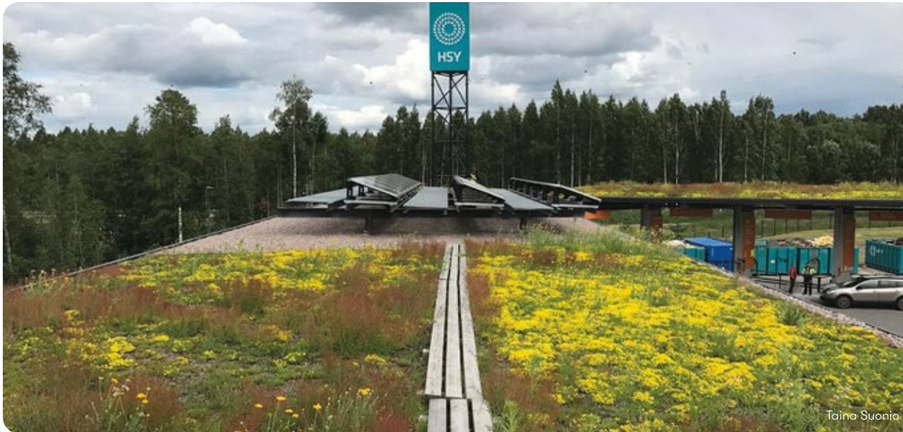
Ruskeasannan Sorttiaseman katto on hyödynnetty hulevesien hallintaan ja aurinkoenergian tuotantoon.
