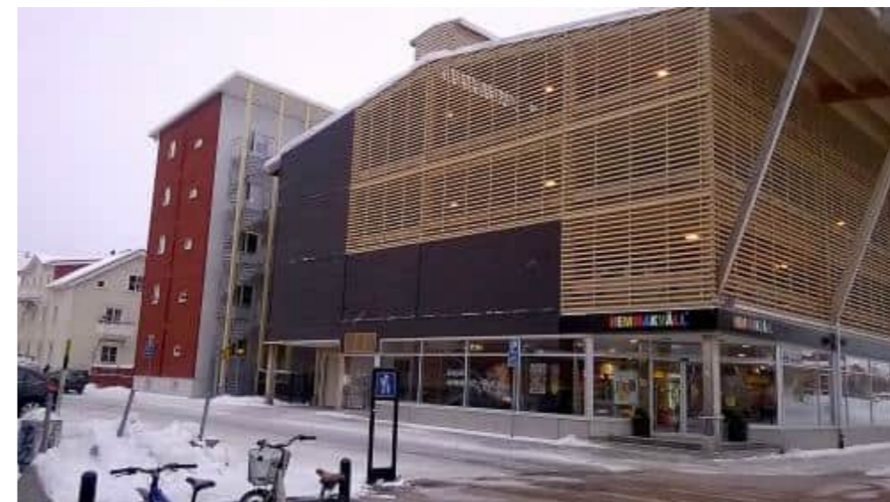
Kuva 26. Puinen pysäköintitalo Ruotsin Skellefteåssa. Kuva: ilkkapohjalainen.fi, Juulia Taanila
