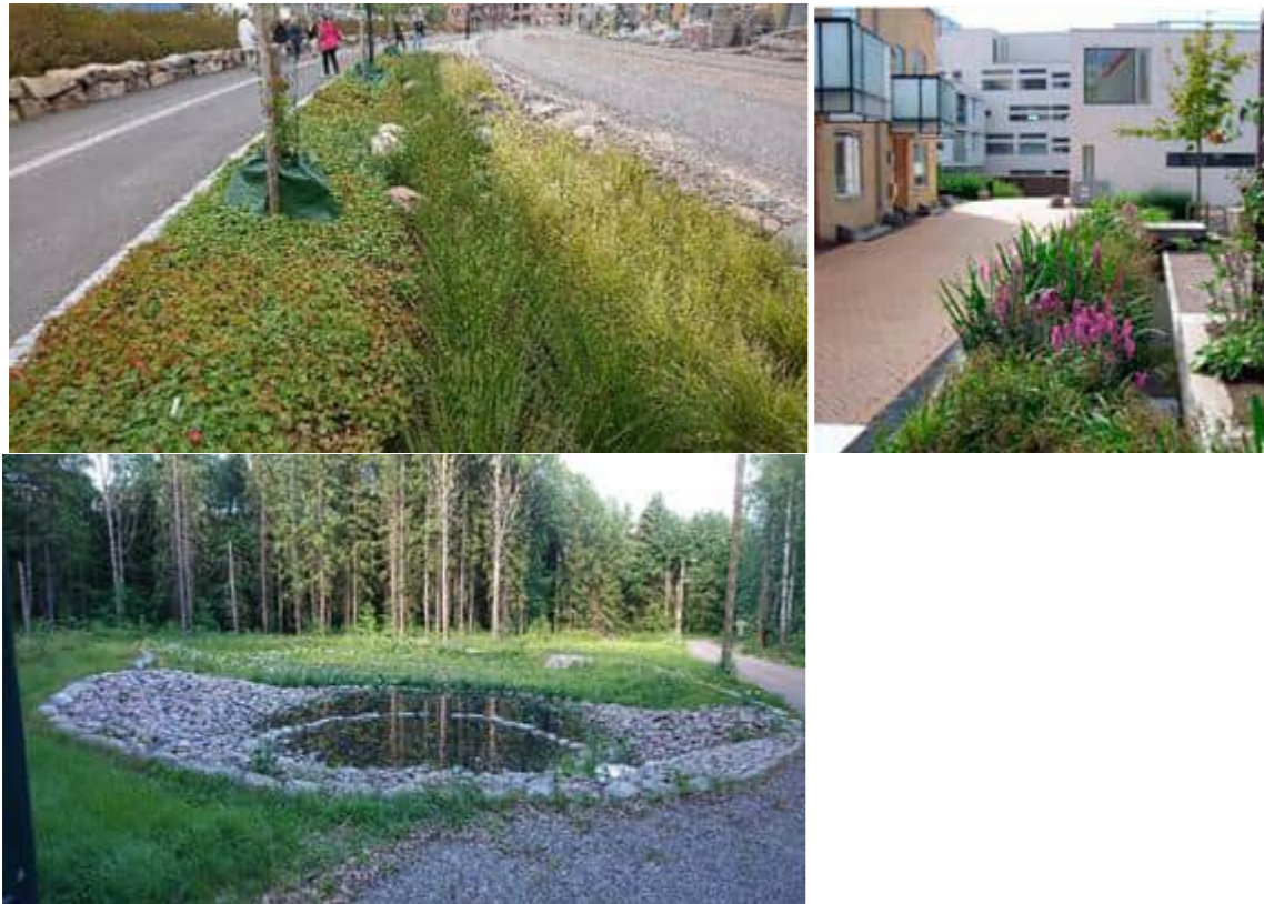
Kuva 48. Katujen hulevesiä pyritään ohjaamaan biosuodattaviin hulevesirakenteisiin istutuskaisioille, joihin mahtuu sekä katupuuistutuksia että kosteutta sietäviä heiniä, saroja ja muuta niittykasvillisuutta. Keskellä esimerkki pihakadun sadepuutarhasta. Oikealla esimerkki hulevesien laskeutusaltaasta ja biosuodatuksesta metsäpuutarhassa.
