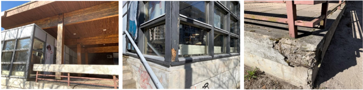
Vaurioita ostoskeskuksen rakenteissa: lahoo, taipumaa, ruostetta ja rapautumista.
