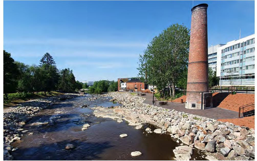
Kuva 4. Tikkurilankosken kunnostaminen on valmistunut.
