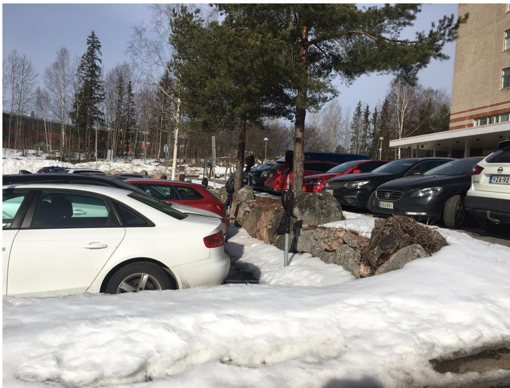
Valokuva: Alueen lounaisosassa pysäköintialuetta on pengerretty kivistä ladotuin tukimuurein.
