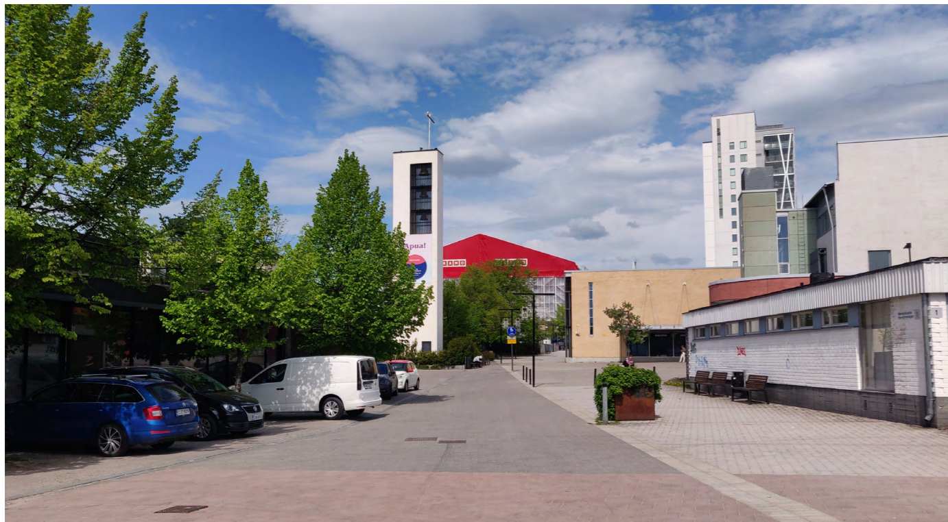
Kuva 24. Näkymä Korsonaukiolta. Vasemmalla puuston takana kirkon rakennuksia, oikealla liikerakennus, Lumo ja taustalla Korson 16-kerroksinen tornitalo. (05/2023)
