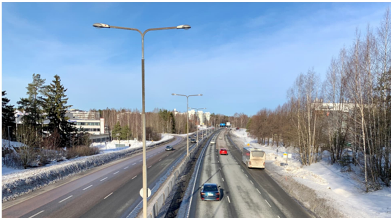
Hämeenlinnanväylä Palotien sillalta pohjoiseen.
