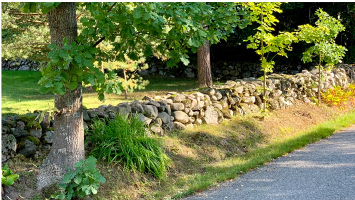
Palotie 10:n tonttia rajaava kivimuuri sijaitsee osin naapuritonttien puolella ja on sammaloitunut. Kaupunginmuseo esitti lausunnossaan suojeltavaksi kivimuurin, mutta ei taloa. TKa 5.9.2024
