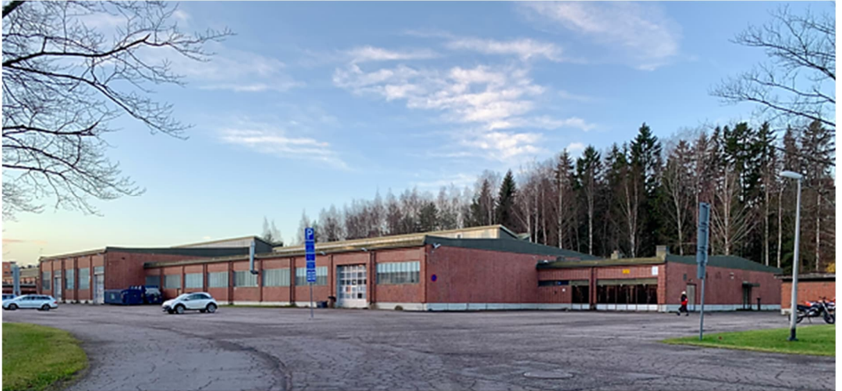
Varian pohjoisosa Louhelantien sisääntulolta nähtynä. Sähköpuoli.
