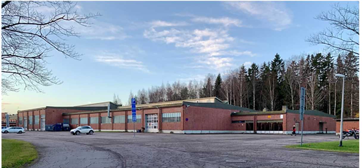
Varian pohjoisosa Louhelantien sisään tulolta nähtynä. Sähköpuoli.
