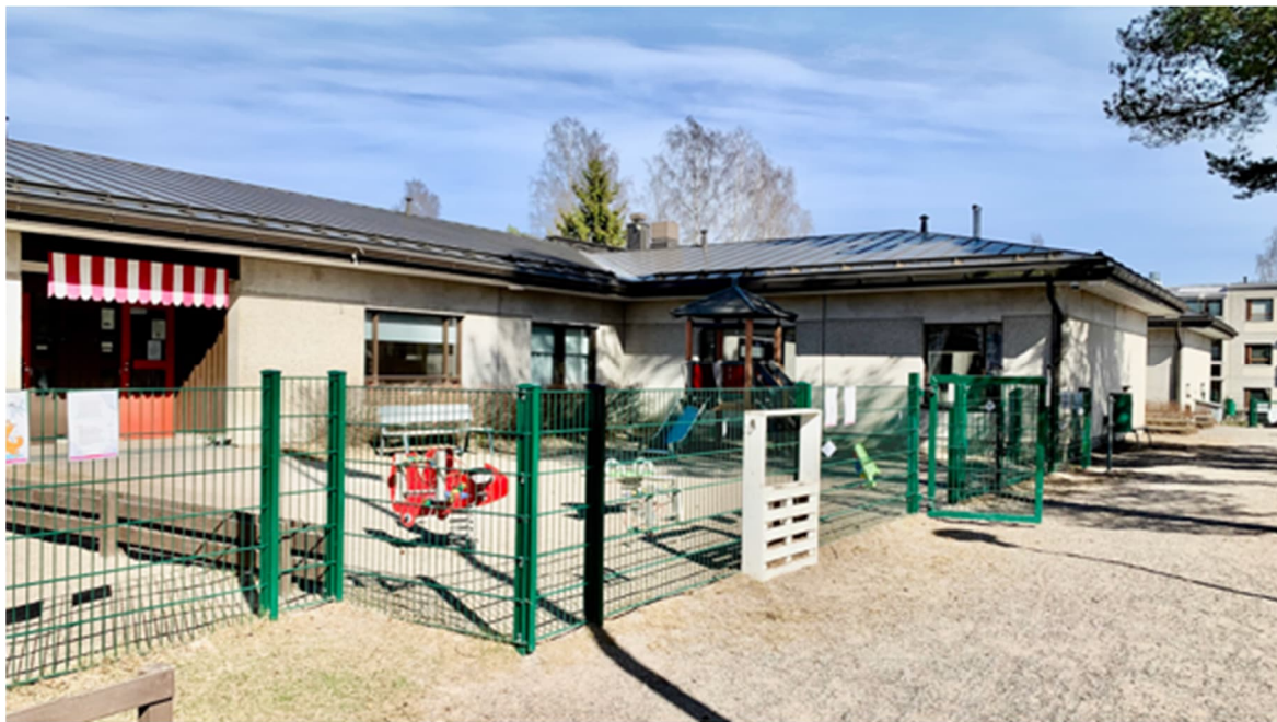
Vantaanlaakson päiväkoti. Julkisivut ovat betonia.
