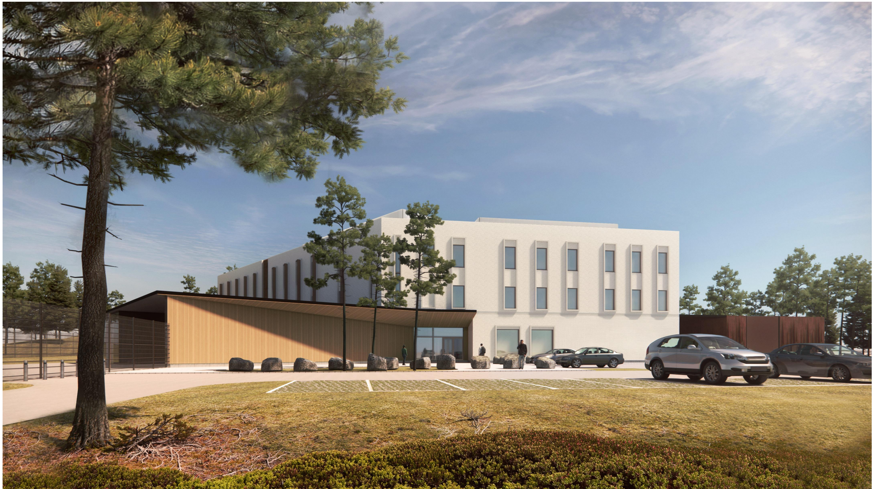
Näkymä Siltaniitynkujalle. Rakennuksen pääsisäänkäynti. Julkisivu itään.
