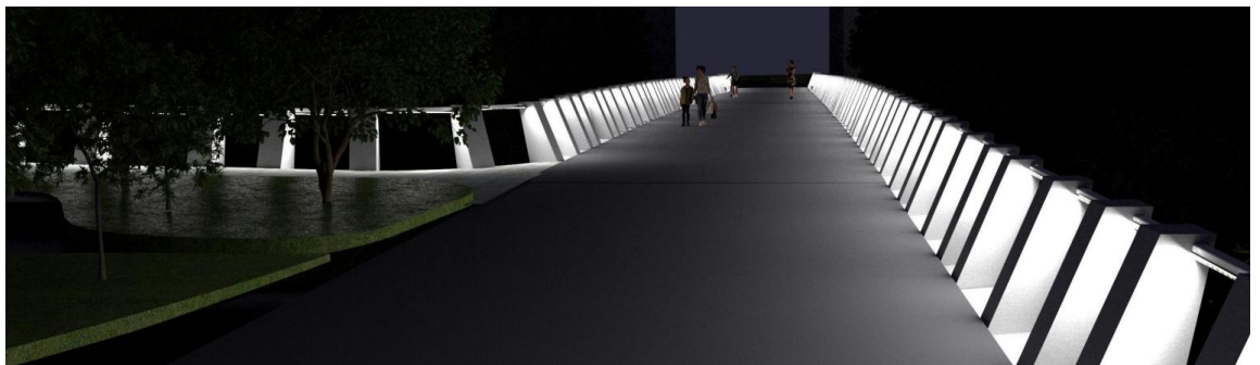
Kuva 34. Siltakannen valaistus (kylmä). (A-Insinöörit Suunnittelu Oy, ARCO Architecture Company Oy)
