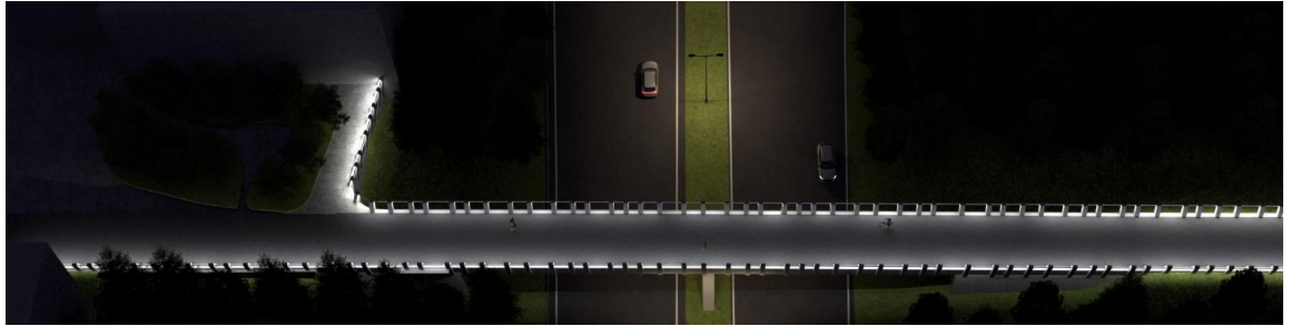
Kuva 32. Valaistuksen kokonaisuus ilmasta katsottuna. (A-Insinöörit Suunnittelu Oy, ARCO Architecture Company Oy)
