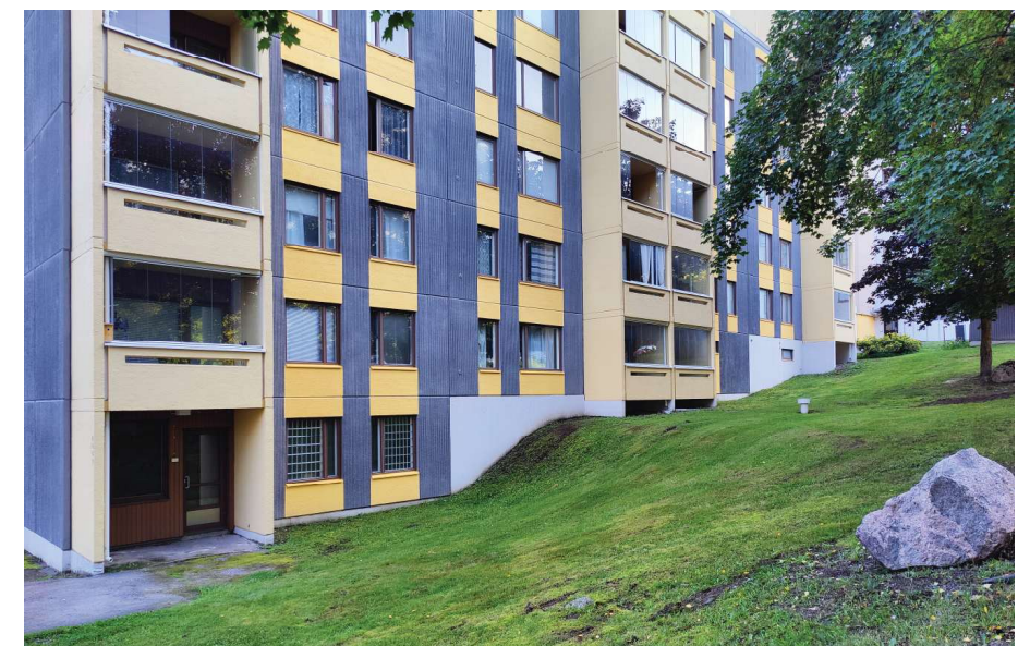
Rasinkatu 14, jossa parvekkeiden ulkoasu on alkuperäinen. Kuvassa näkyy parvekkeiden tummanväriset takaseinät. Kuva: Sudar Gunasekaran, 2024.
