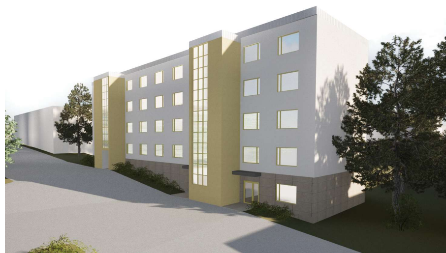
Esimerkkisuunnitelmissa on tutkittu rappausta uutena julkisivumateriaalina. Rappauksen etuna on pintakäsittelyn monipuoliset mahdollisuudet. Kuvassa Rasinkatu 5 on saanut rapatun julkisivun, lisäkerroksen ja porrashuoneen laajennuksen. Kuva: Suvi Raski, 2025.
