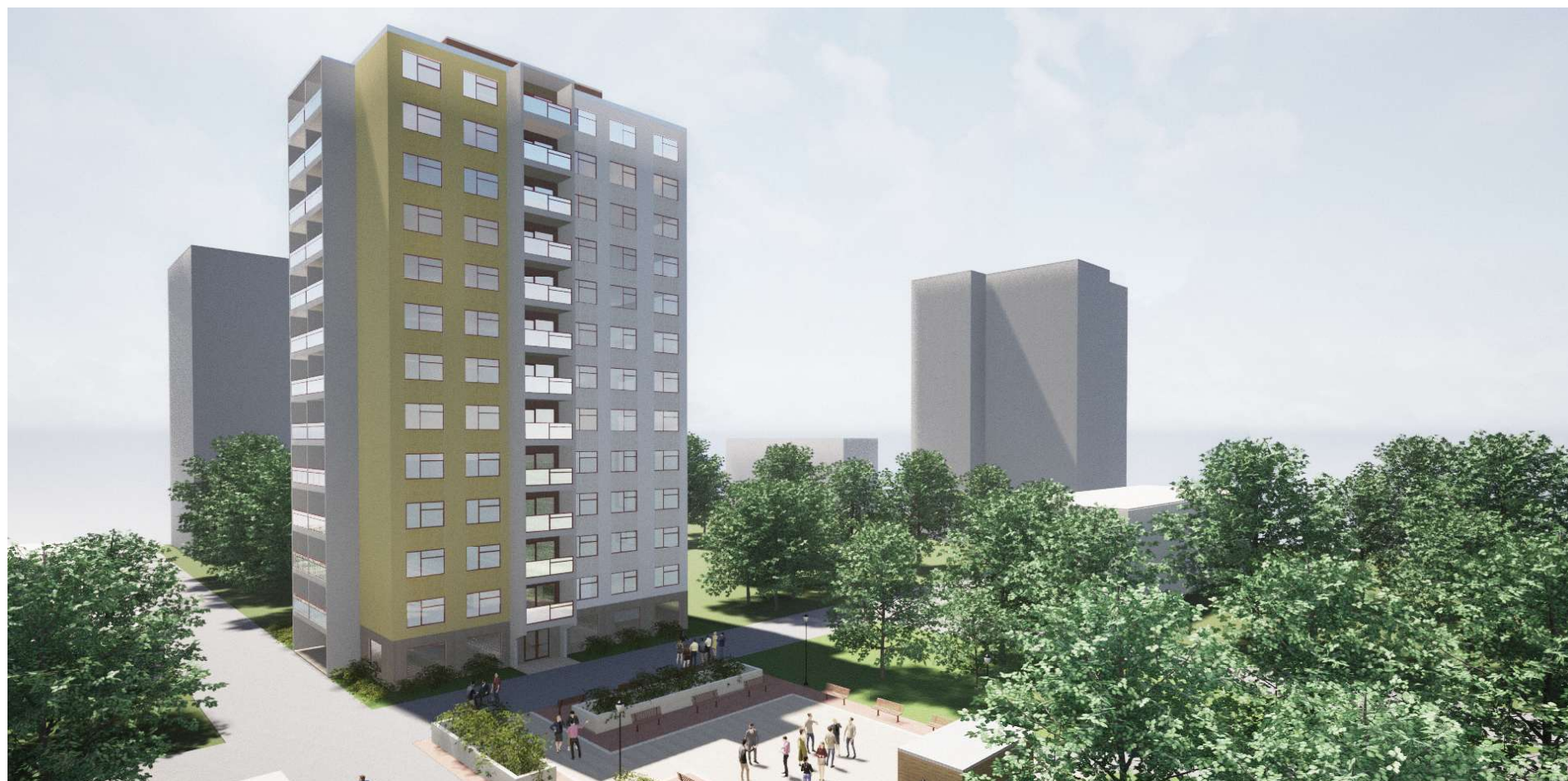
Rasinkatu 10:n on esimerkkisuunnitelmassa lisätty uudet parveketornit, joiden muotokieli vastaa alkuperäisiä. Kuva: Suvi Raski, 2025
